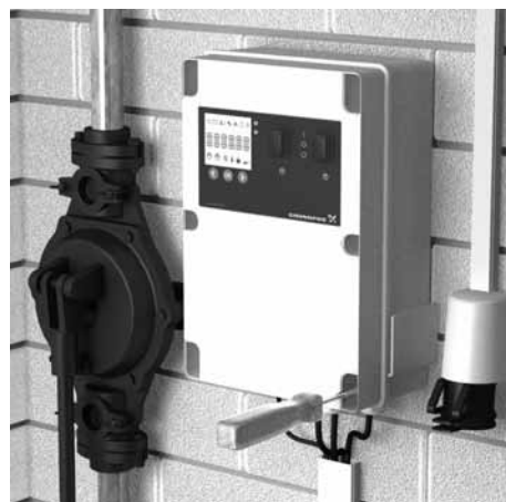
Abb. 8 Anbringen der Steuerung LC 221
