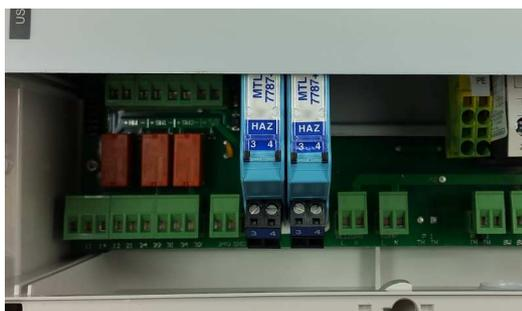
Abb. 2 Stück Zenerbarrieren in 2-Pumpen
