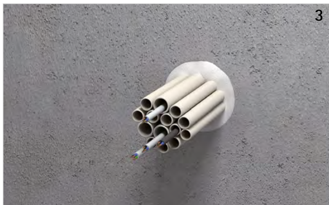
3 Restspalte mit z. B. Walraven Pacifyre® FPM Brandschutzmörtel verschließen.
