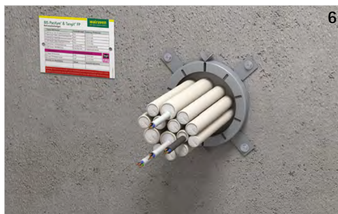
6 Das Kennzeichnungsschild ausfüllen und neben der Abschottung anbringen.
